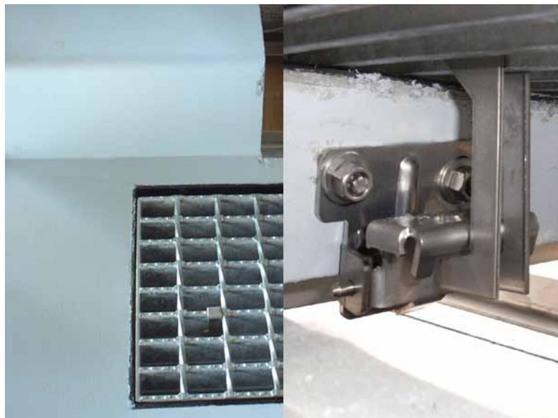
GST-SPM/縁塊への設置例 (上部)/(内部)
