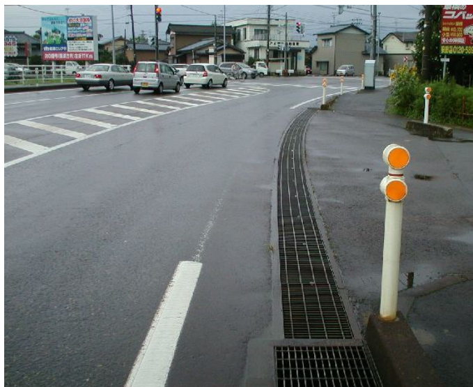
グレーチングストッパー(タイプ I 型)の設置例
