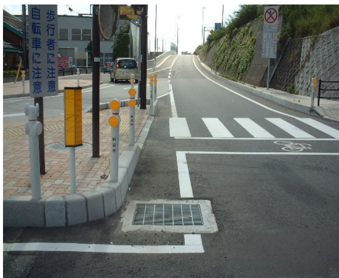
グレーチングストッパー(タイプ III 型)の設置例
