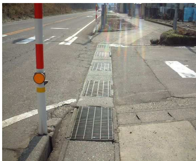
グレーチングストッパー(タイプⅡ型)の設置例
