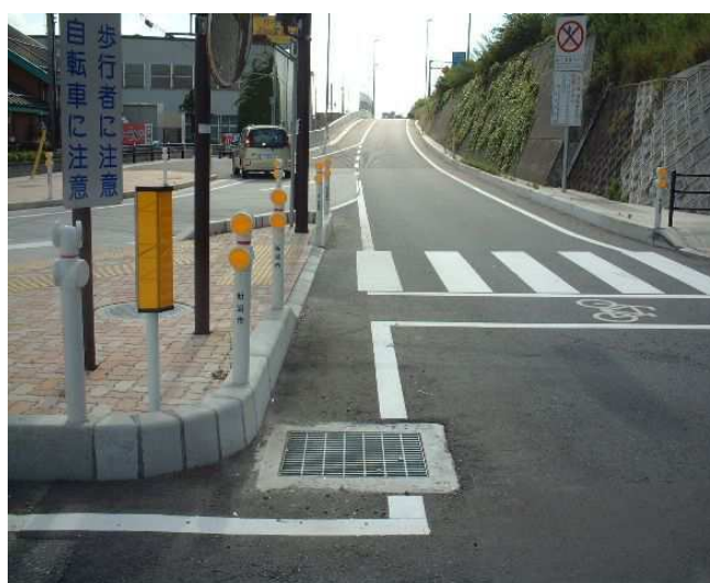
グレーチングストッパー(タイプⅢ型)の設置例
