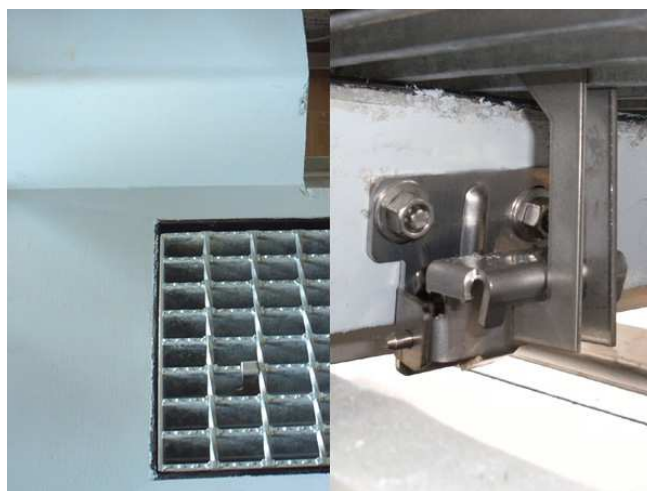
GST-SPM/縁塊への設置例(上部)/(内部)
