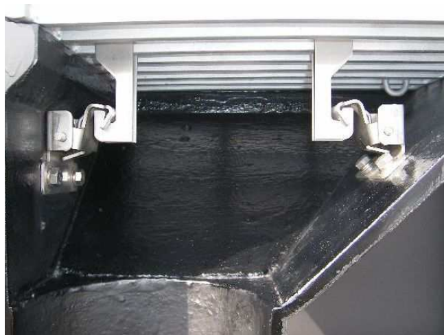
GST-SSP/橋梁・高架排水柵(鑄鉄製)の設置例
